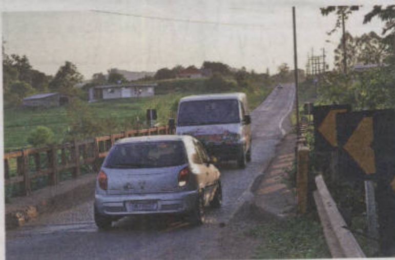
Duplicação da ponte na ERS-413 em São Bento é prometida há vários anos
