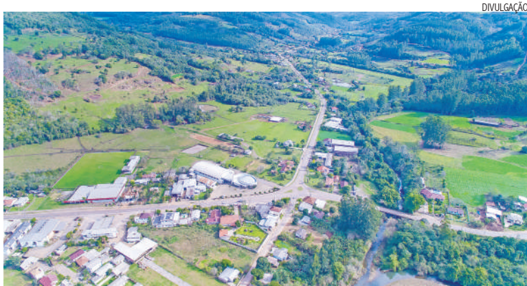
Extensão da ciclovia é de 2,7 mil metros, a partir do Trevo do Peteba
