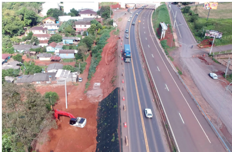
Concessionária também inicia construção de mais uma passarela
