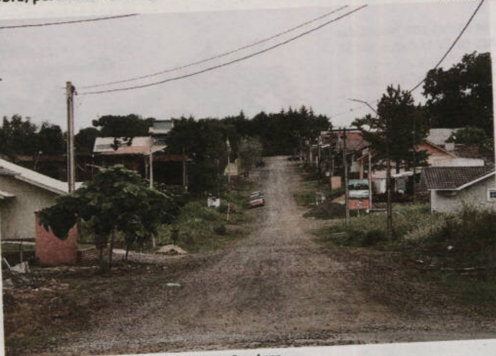
Serão gastos R$ 11,5 milhões em pavimentação urbana
