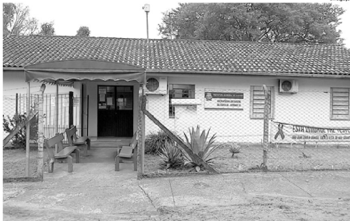
MELHORIA: obra custará R$ 41 mil
