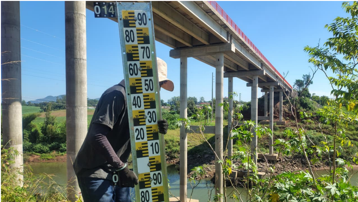
Equipamentos serão instalados nos pilares da travessia entre Lajeado e Arroio do Meio
