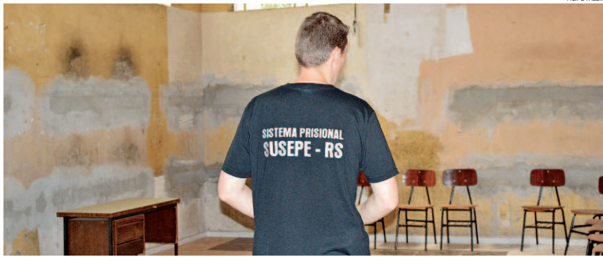
Pavilhões de trabalho ficarão na antiga área do albergue do semiaberto. Reforma custará cerca de R$ 80 mil
