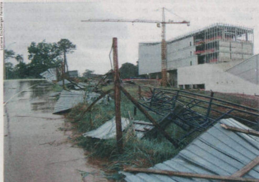
Vento forte derrubou tapumes que protegiam obra na Univates
