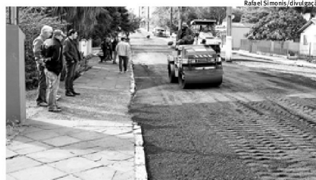
CAPEAMENTO: asfalto é aplicado em trecho da via
