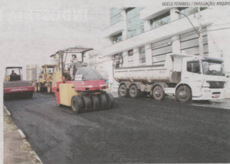
Finalização dos trechos de pavimentação do centro deve ocorrer em até 60 dias
