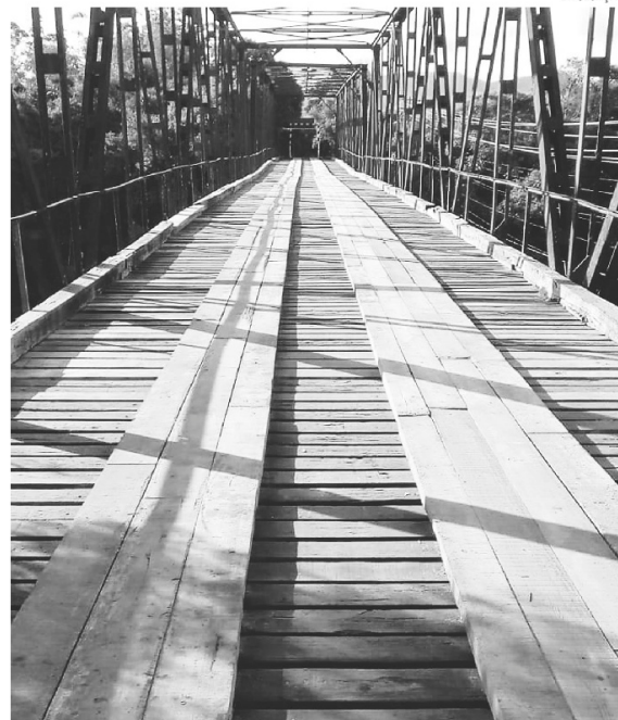
Pranchões de madeira foram substituídos no lado de Lajeado
