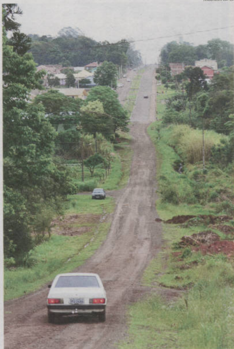
Trecho da Av. Amazonas deverá receber pavimentação asfáltica no próximo ano
