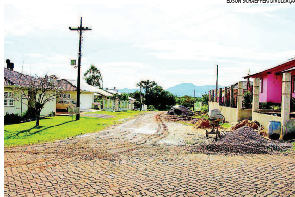
Trecho da rua Gustavo Ahlert receberá pavimento em blocos de concreto
