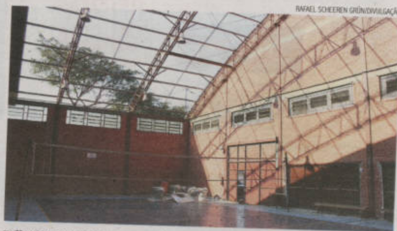
Telhados novos prometem acabar com as goteiras nos ginásios do parque
