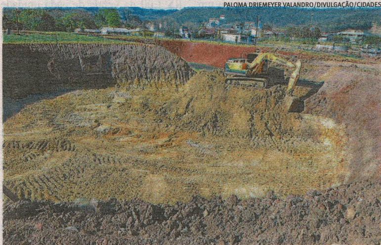
Novo frigorífico de aves deve aumentar a capacidade de abate na planta
