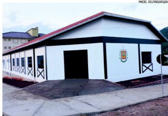
A obra avaliada em R$ 710 mil foi construída sem recursos do Estado
