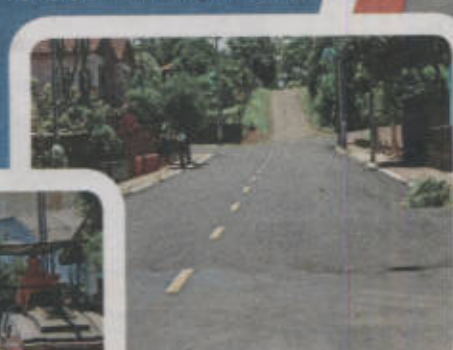
ASFALTO NA RUA MARECHAL HERMES
