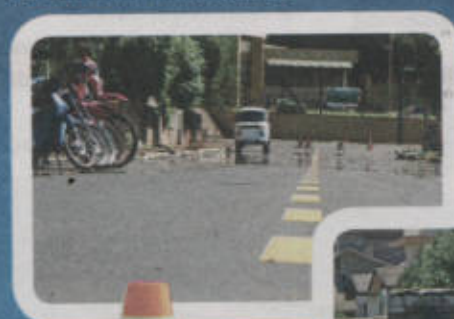
ASFALTO NA RUA MENNA BARRETO
