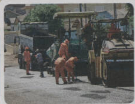
ASFALTO NA RUA HENRIQUE WENDT
