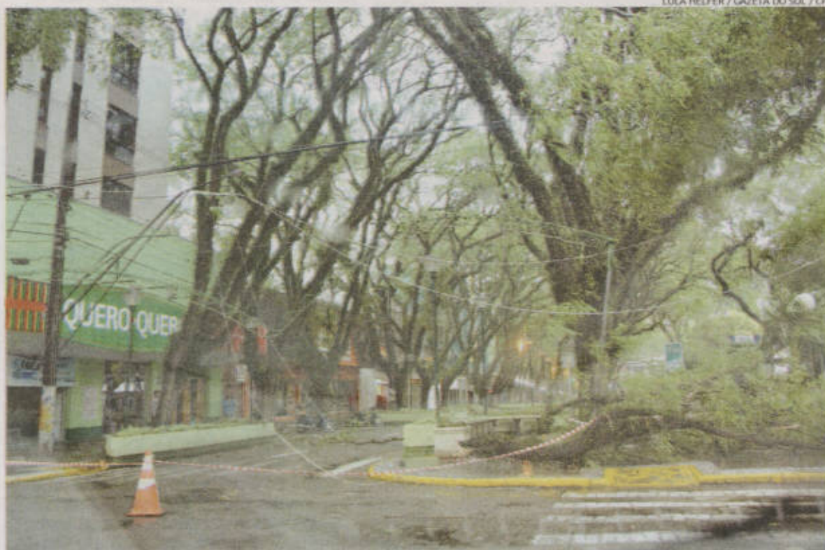
Santa Cruz registrou 300 casas com danos nas coberturas e queda de galhos em vários pontos da cidade
