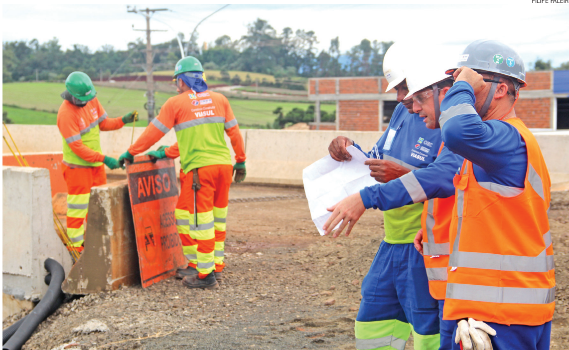
Viaduto entre os bairros Olarias e Montanha deve ficar pronto em um mês. Trânsito voltou a ser interrompido
