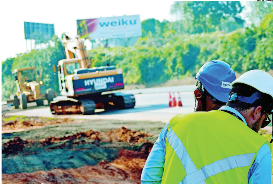
Construção da praça em Paverama mudou o trânsito na BR. Cobrança do pedágio começa em fevereiro de 2020
