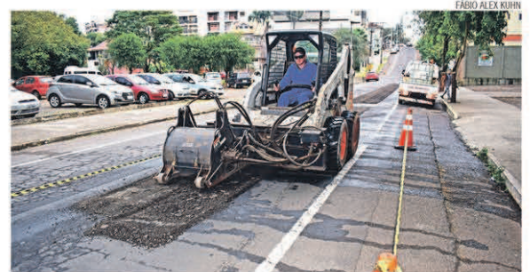
Máquinas da administração trabalharam ontem na rua João Abbott
