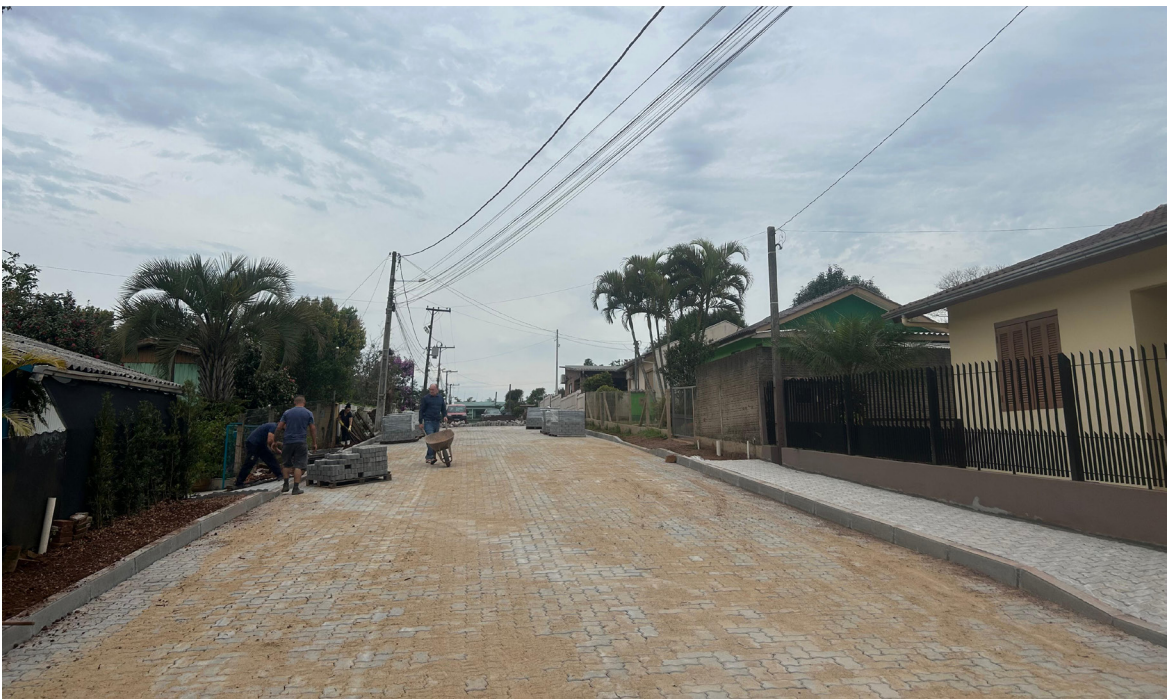
Rua Francisco Tieze, no Moinhos d'Água, foi uma das vias pavimentadas e já entregue à comunidade
