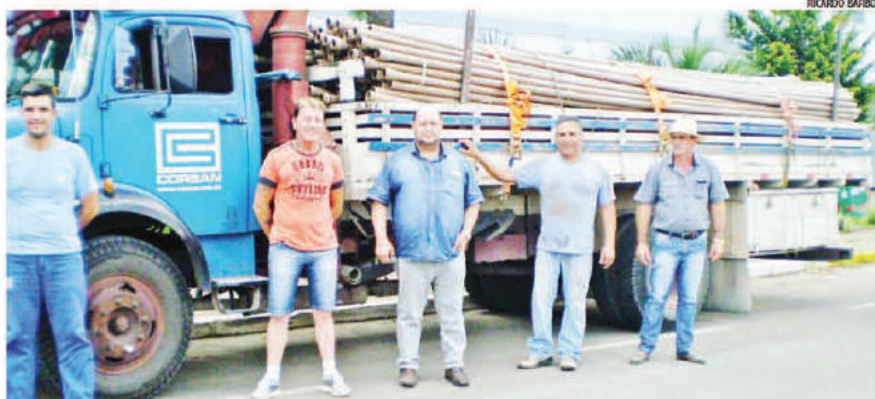
Obras começarão na primeira quinzena de janeiro. Rede no Passo conta com 3,2 mil metros de extensão
