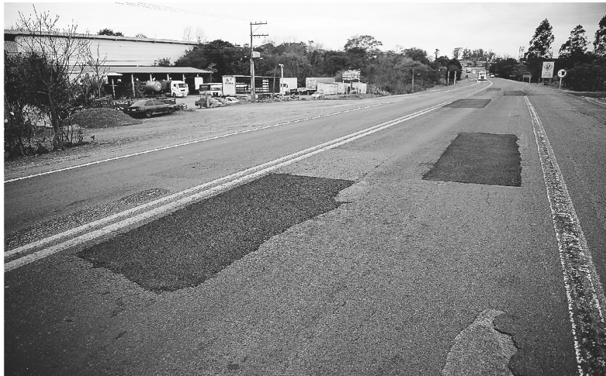
Em Lajeado, concessionária faz microrrevestimento asfáltico
