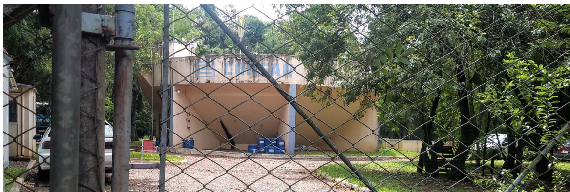
Estação de Tratamento de Esgoto no Moinhos atende 340 residências. Perspectiva da Corsan é passar de 800 neste ano
