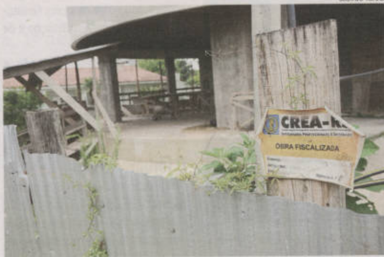
Há 7 anos, construção foi paralisada no décimo andar após intervenção do MP
