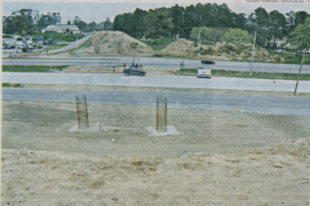
Execução, prejudicada por problemas burocráticos envolvendo a empresa responsável, deve terminar em janeiro
