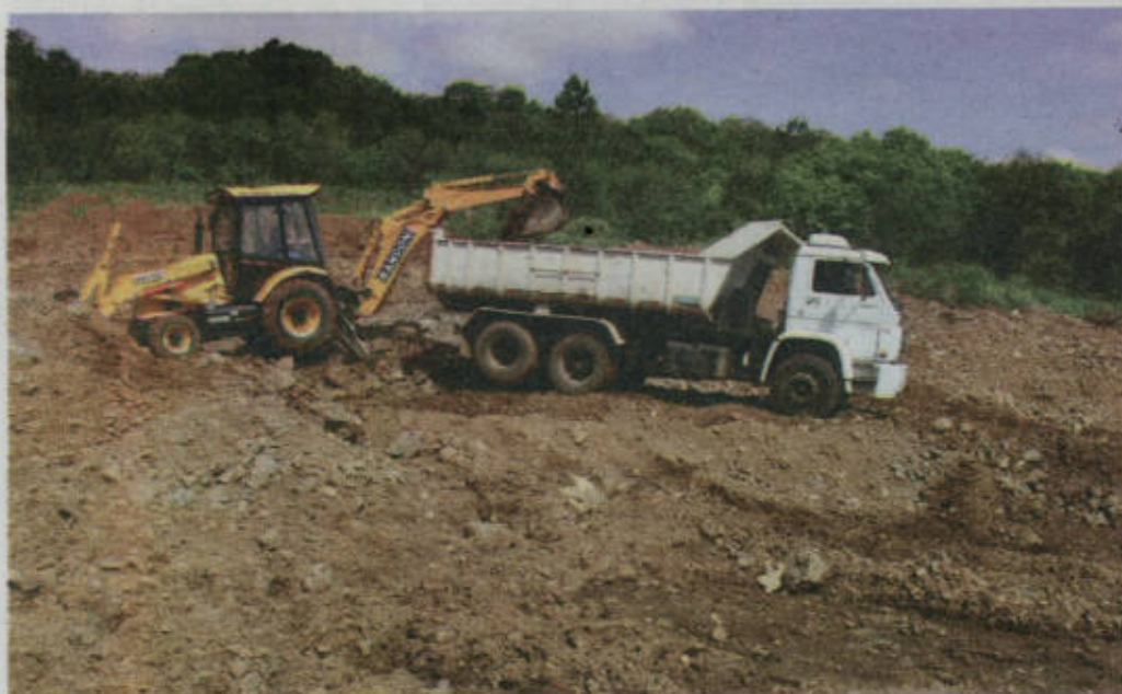
Máquinas trabalhando na retirada de saibro
