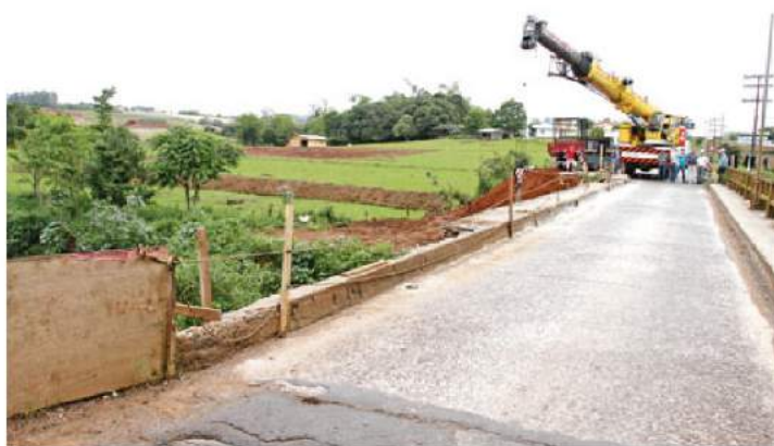
PONTE: ontem, peças de concreto foram descarregadas no local da obra
