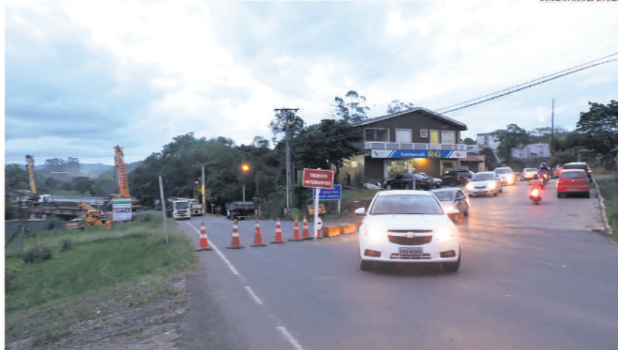
Local ficará isolado até a conclusão da instalação de vigas e posterior junção das duas partes da ponte
