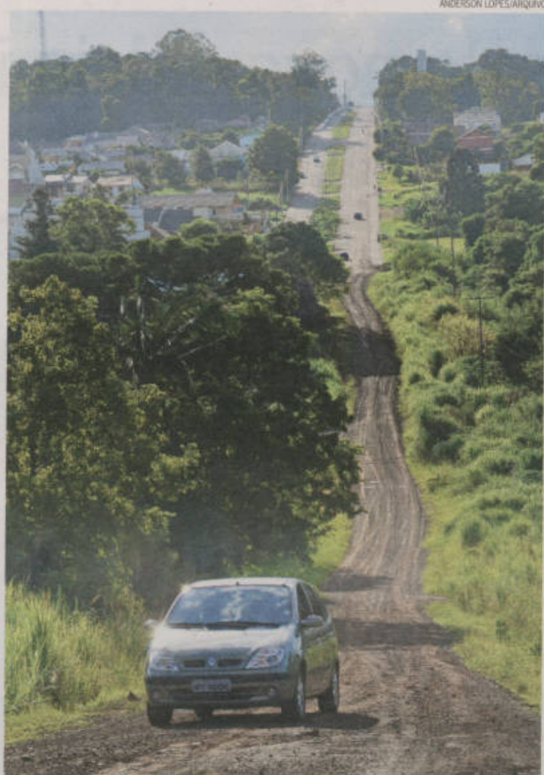
Pavimentação de trecho da Av. Amazonas, no bairro Universitário, está prevista
