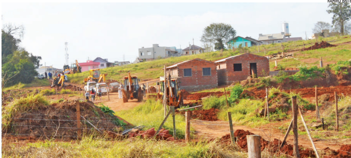
Máquinas da Secretaria de Obras obstruíram a passagem em área com moradias irregulares na tarde de ontem
