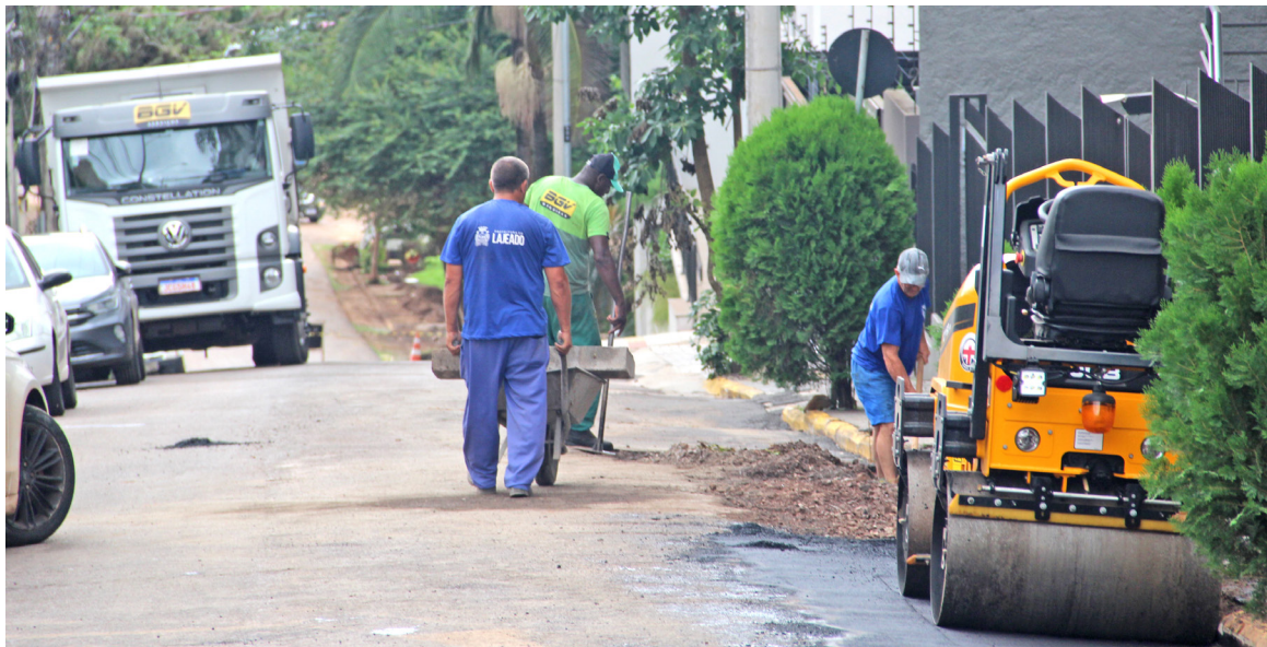
Equipe da Secretaria de Obras de Lajeado trabalhava no local na tarde de ontem
