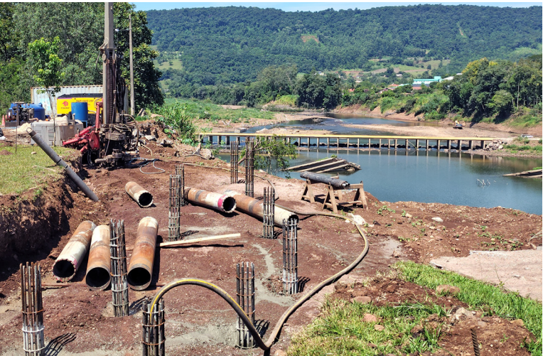
Nova ponte sobre o Forqueta substitui estrutura que colapsou nas cheias
