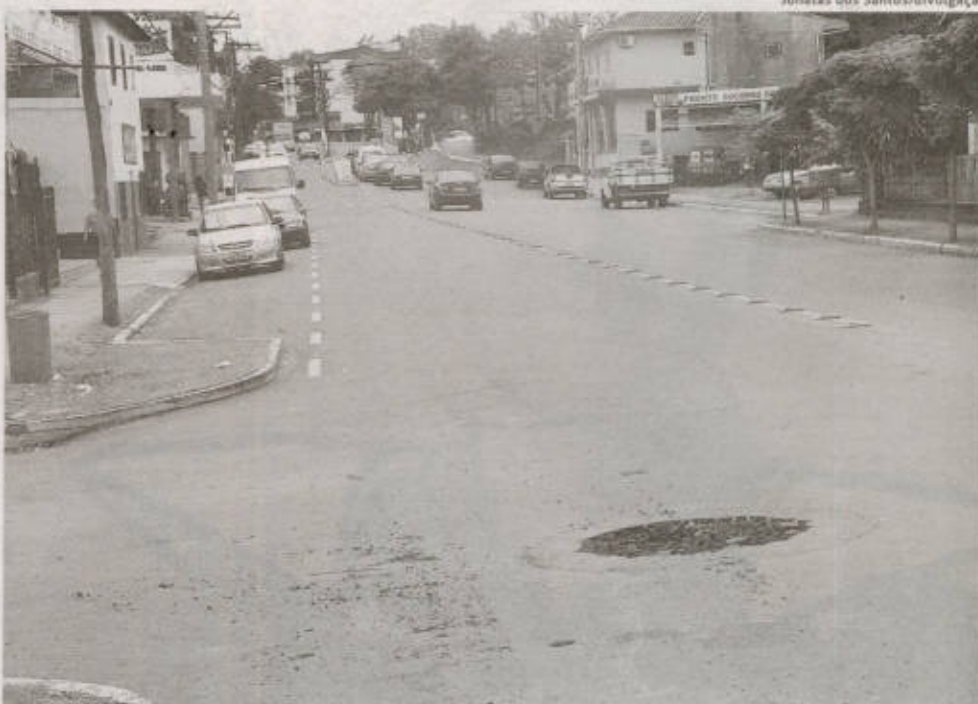
Foram abertos oito buracos para cabeamento
