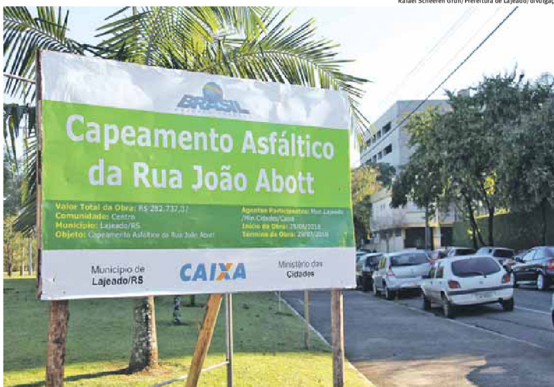
RUA JOÃO ABOTT: capeamento asfáltico terá investimento de R$ 282,7 mil
