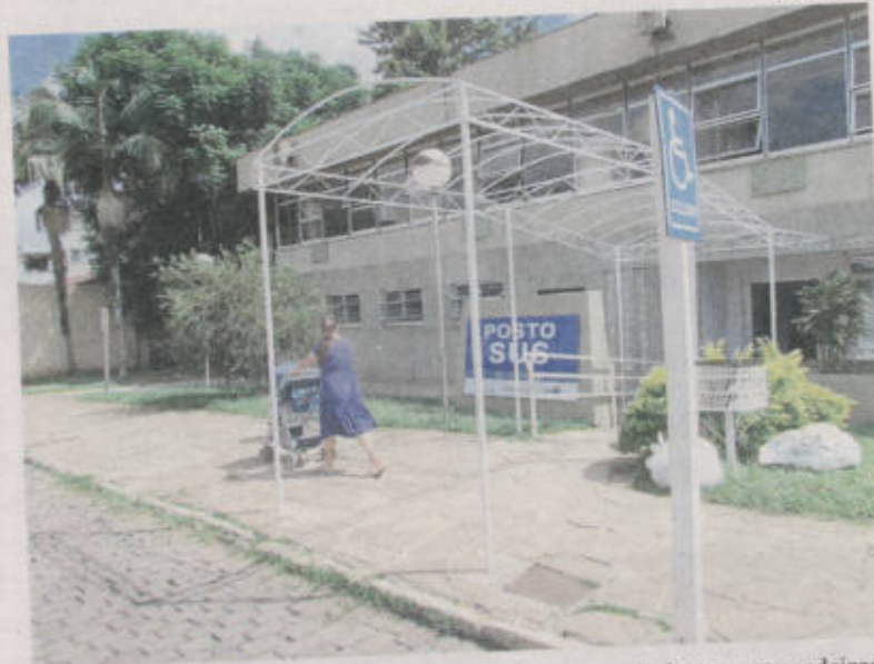
Obra custou R$ 25 mil. Resta colocação de toldo e troca de bancos por cadeiras
