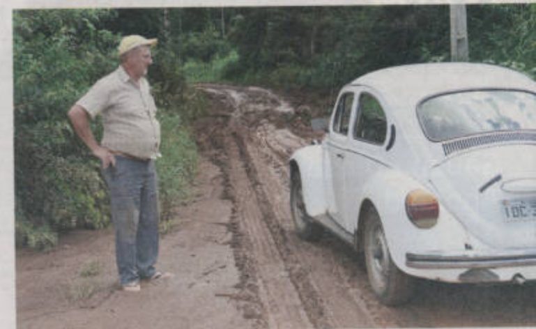
Hermann reclama do barro formado devido a ausência de valetas
