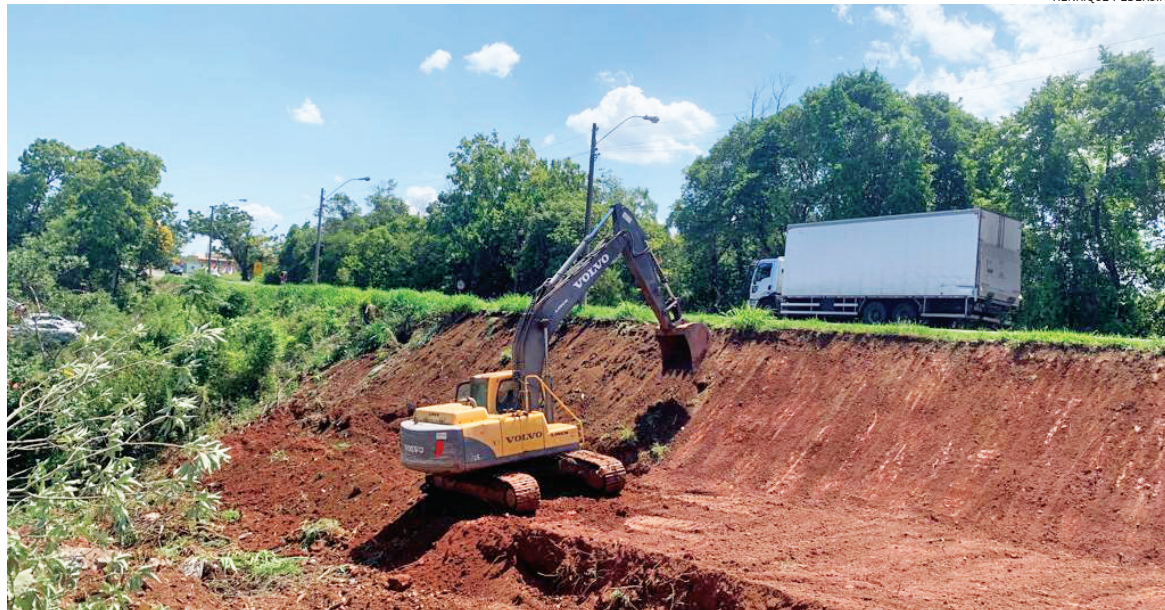
Construtora iniciou escavações das vias laterais à ERS-130. Melhorias no trecho incluem viaduto e rótulas
