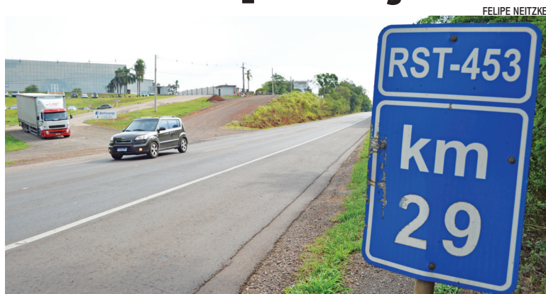
Os 30 km da rodovia serão recuperados em obra que deve terminar em agosto
