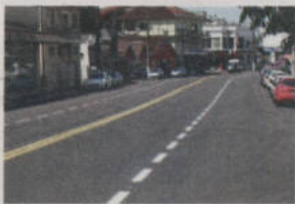
PAVIMENTAÇÃO VIÁRIA A MAIOR OBRA DE PAVIMENTAÇÃO DA HISTÓRIA
