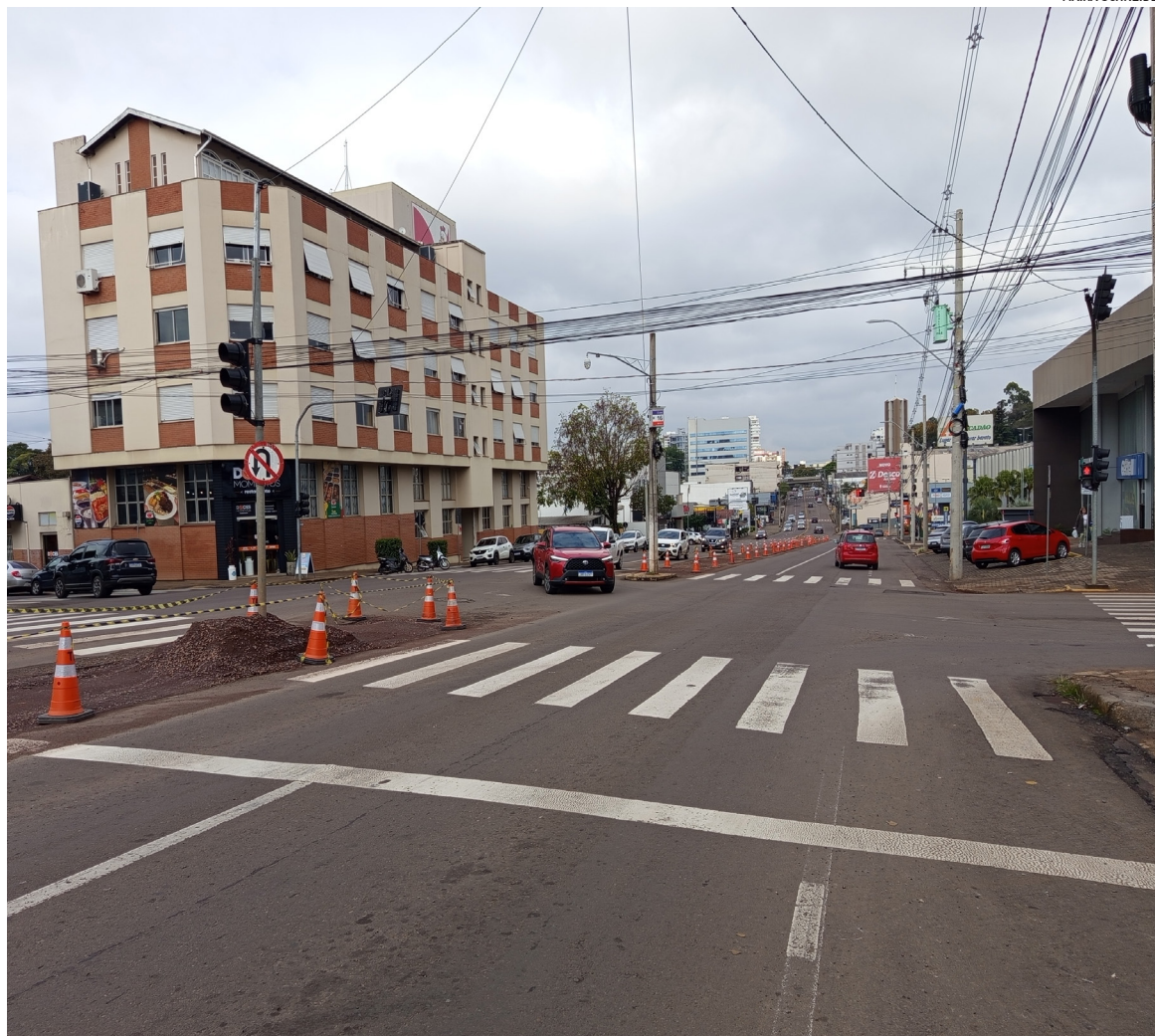
Etapa crucial para avanço do projeto foi concluída no domingo. Próximas intervenções devem iniciar hoje
