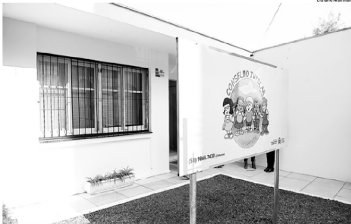
ESPAÇO: salas climatizadas e funcionais de acordo com as necessidades
