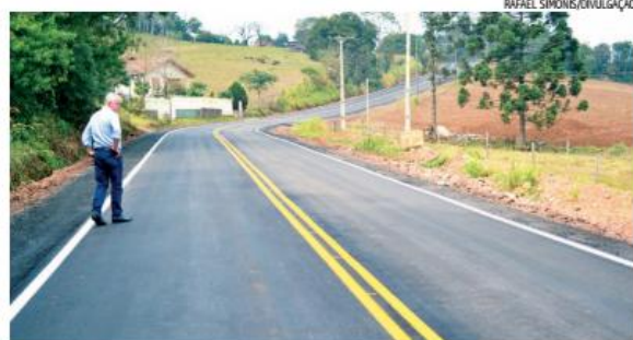
Pavimentação de trecho de 1,7km será entregue neste sábado, dia 2
