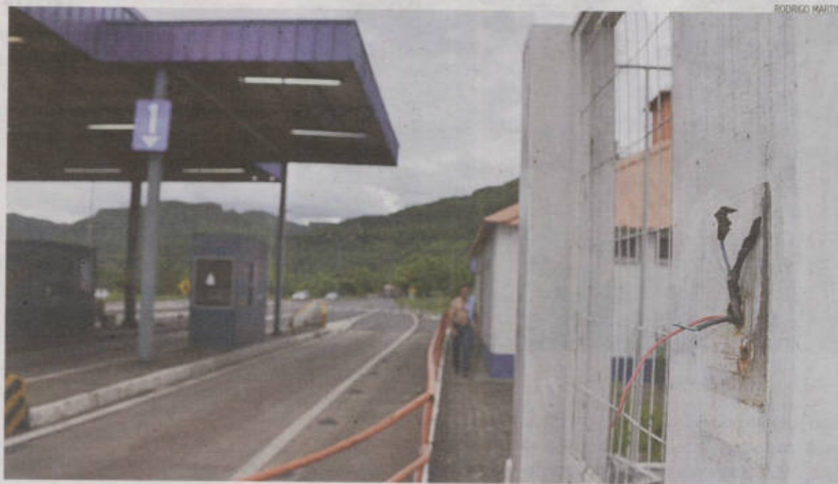
Em Marques de Souza, praça de pedágio sofre com ação de vândalos. Previsão do Dnit é demolir ainda em maio toda a estrutura
