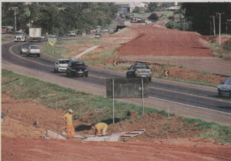
Desde 2010, quando começou a obra, foram liberados 22 quilômetros dos 33,8 previstos
