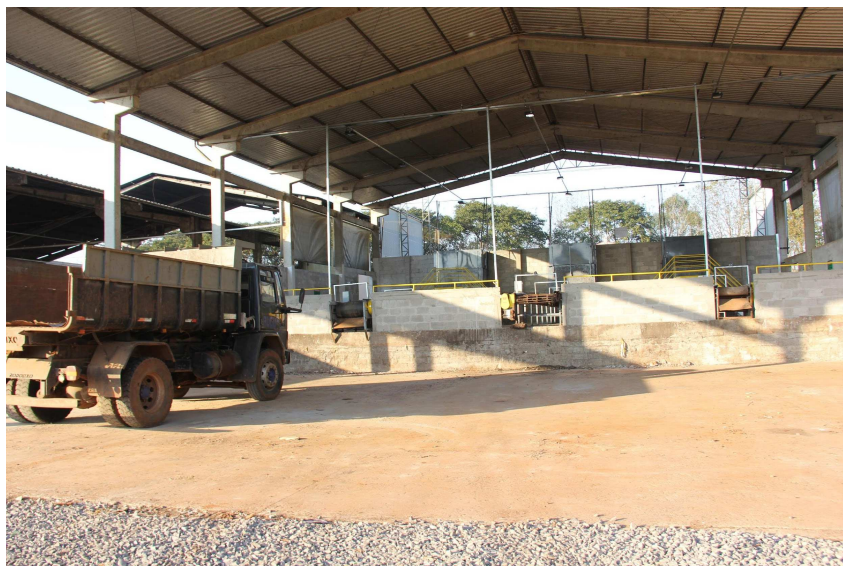
Foto 13: Vista geral do pavilhão 2 de triagem após a reforma.
