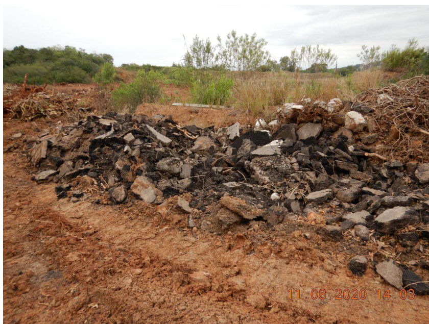
Foto 59: Resíduos de asfalto aterrados;
