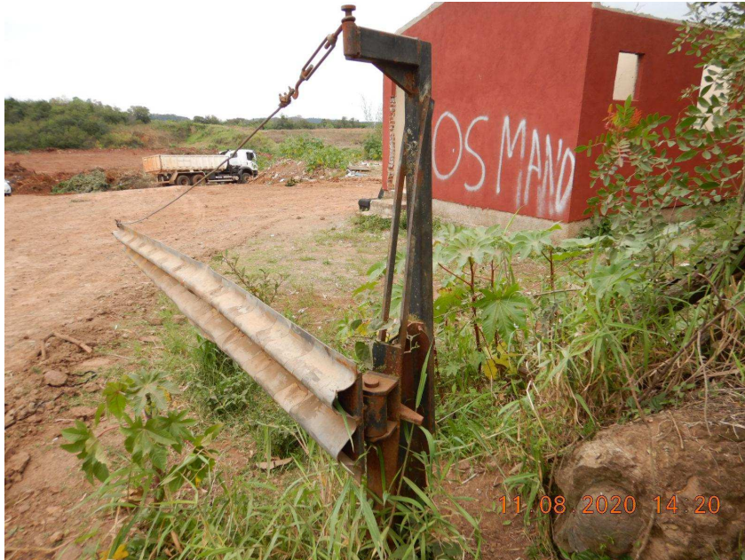
Foto 68: Detalhe do “portão” de acesso.
