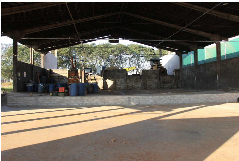
Foto 18: Pavilhão 1 após as reformas.
