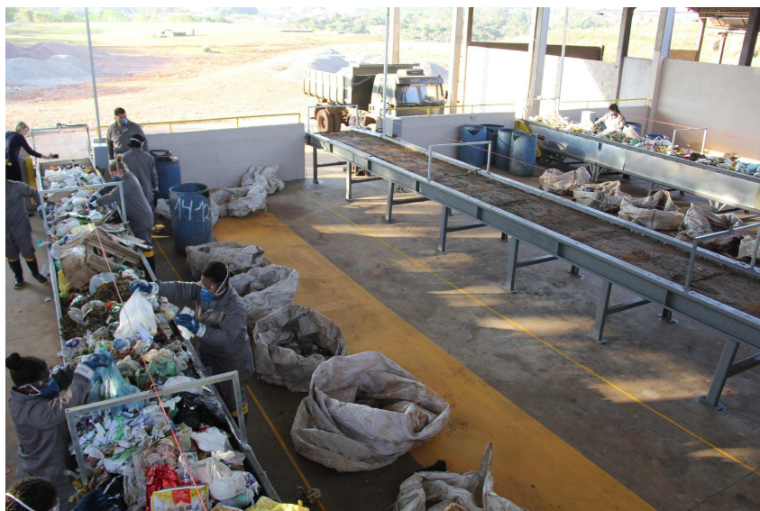
Foto 12: Pavilhão 1 com piso e rede elétrica reformada.
