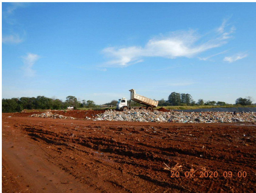
Foto 36: Caminhão descarregando o material mineral para cobertura.
