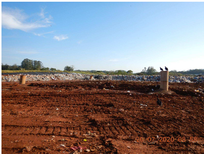
Foto 35: Detalhe da drenagem de gases e cobertura da célula
