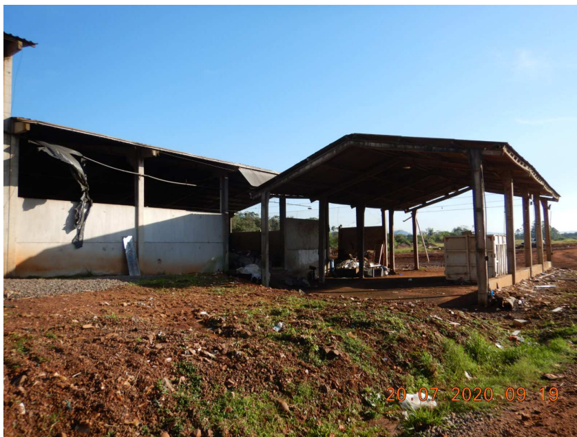
Foto 75: Pavilhão de recebimento e desmontagem de resíduos volumosos;
