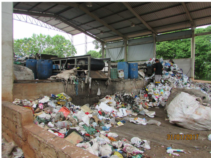
Foto 11: Pavilhão 2 antes das reformas.
