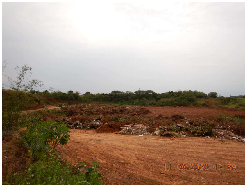
Foto 52: Vista geral do local de aterro;
