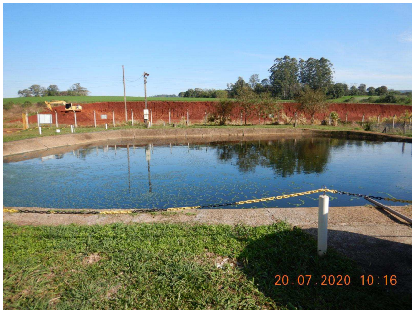
Foto 41: Lagoa de armazenamento, 2020;
