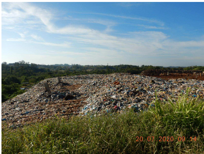
Foto 37: Área com falta de material de cobertura.
