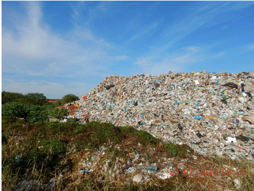
Foto 38: Taludes instáveis, constituídos apenas por resíduos.
