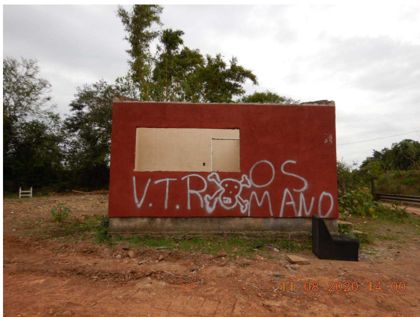
Foto 55: Antiga residência existente no local.
