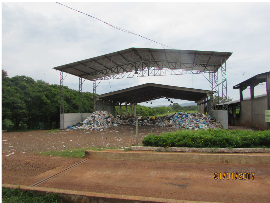
Foto 10: Área de descarga de RSU antes das reformas
