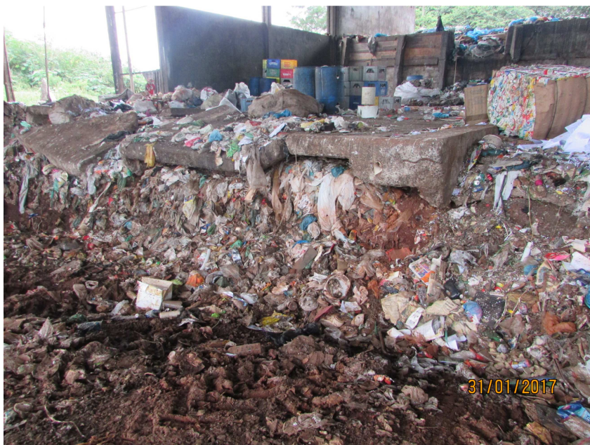
Foto 8: Pavilhão 1 antes das reformas
