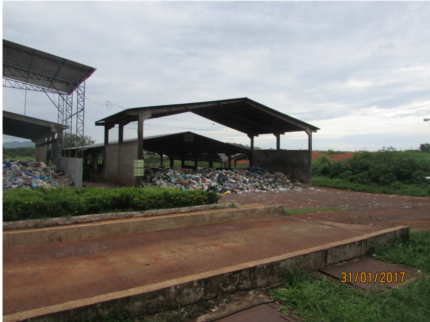
Foto 7: Pavilhão 1 antes das reformas
