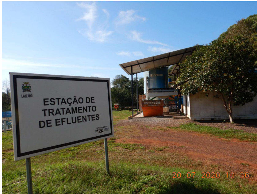
Foto 45: Entrada da Estação de Tratamento;
