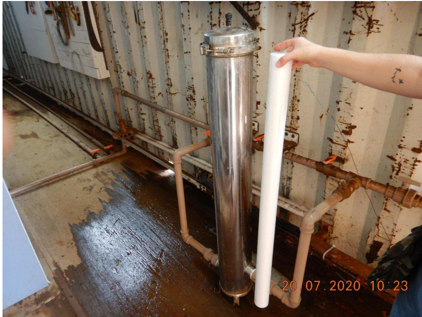
Foto 43: Sistema de microfiltração e cartucho utilizado;
