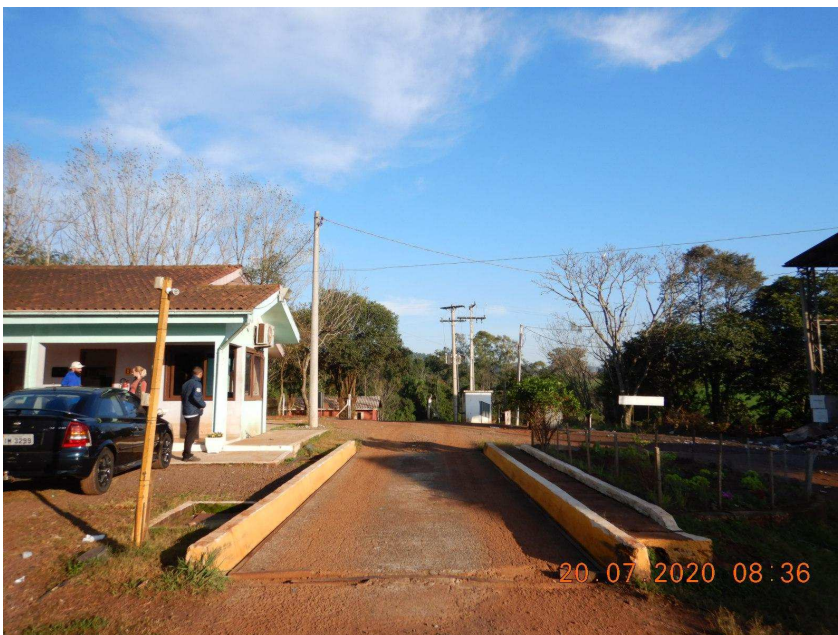
Foto 4: Balança rodoviária instalada.
