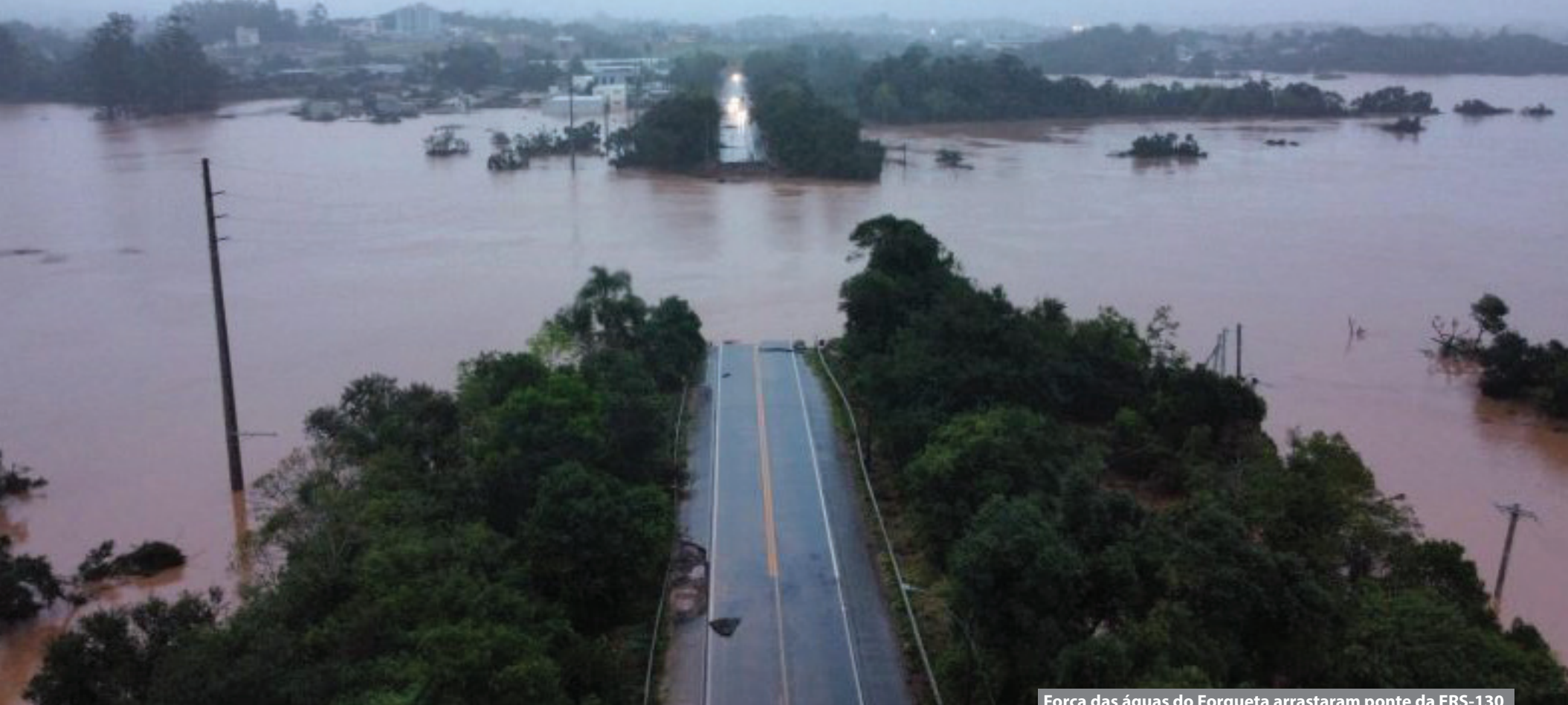
Força das águas do Forqueta arrastaram ponte da ERS-130
