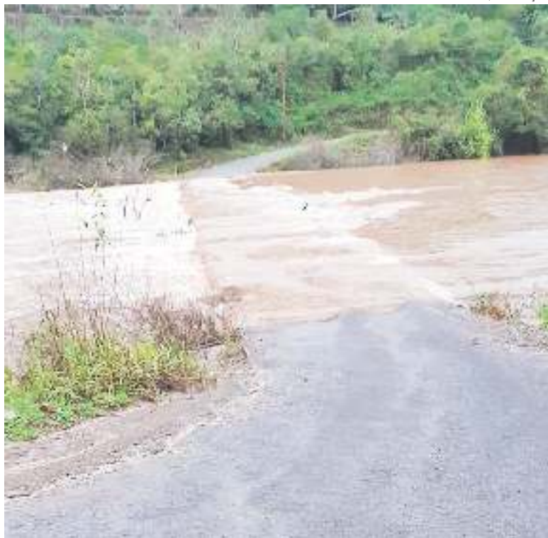
Pela manhã, ponte sobre o Rio Guaporé já impedia a ligação com Anta Gorda
