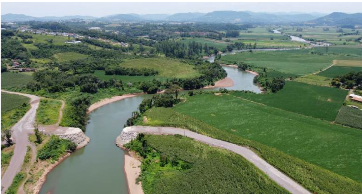
Nova ponte entre Lajeado e Arroio do Meio, no local onde estava a estrutura do Exército, é um dos projetos de travessias no Rio Forqueta
