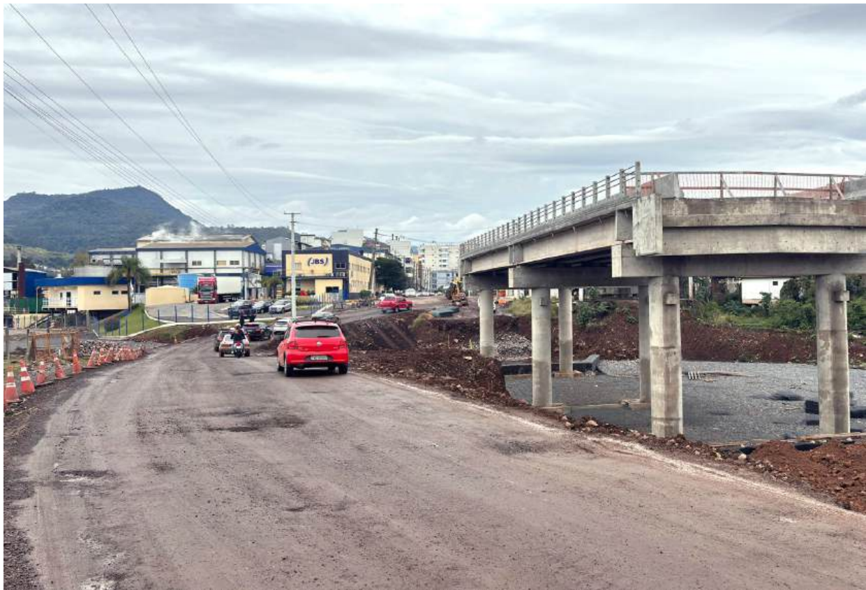
Em Roca Sales, ponte na Av. General Daltro Filho está em fase final, e custou R$ 14,1 milhões, com recursos da Defesa Civil Nacional
