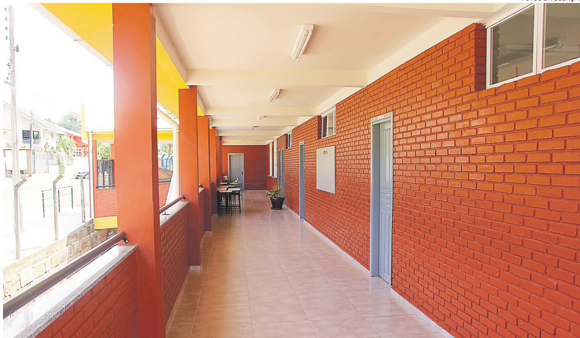
Emef Universitário ampliou estrutura com segundo pavimento
