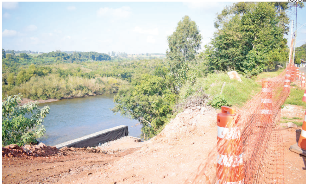
Paralisação ocorreu no fim do mês de abril. Cerca de 30% do muro está concluído
