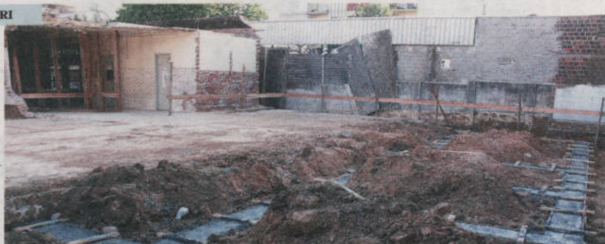
Posto do Centro de Lajeado está sendo reformado. Previsão de conclusão é março de 2014
