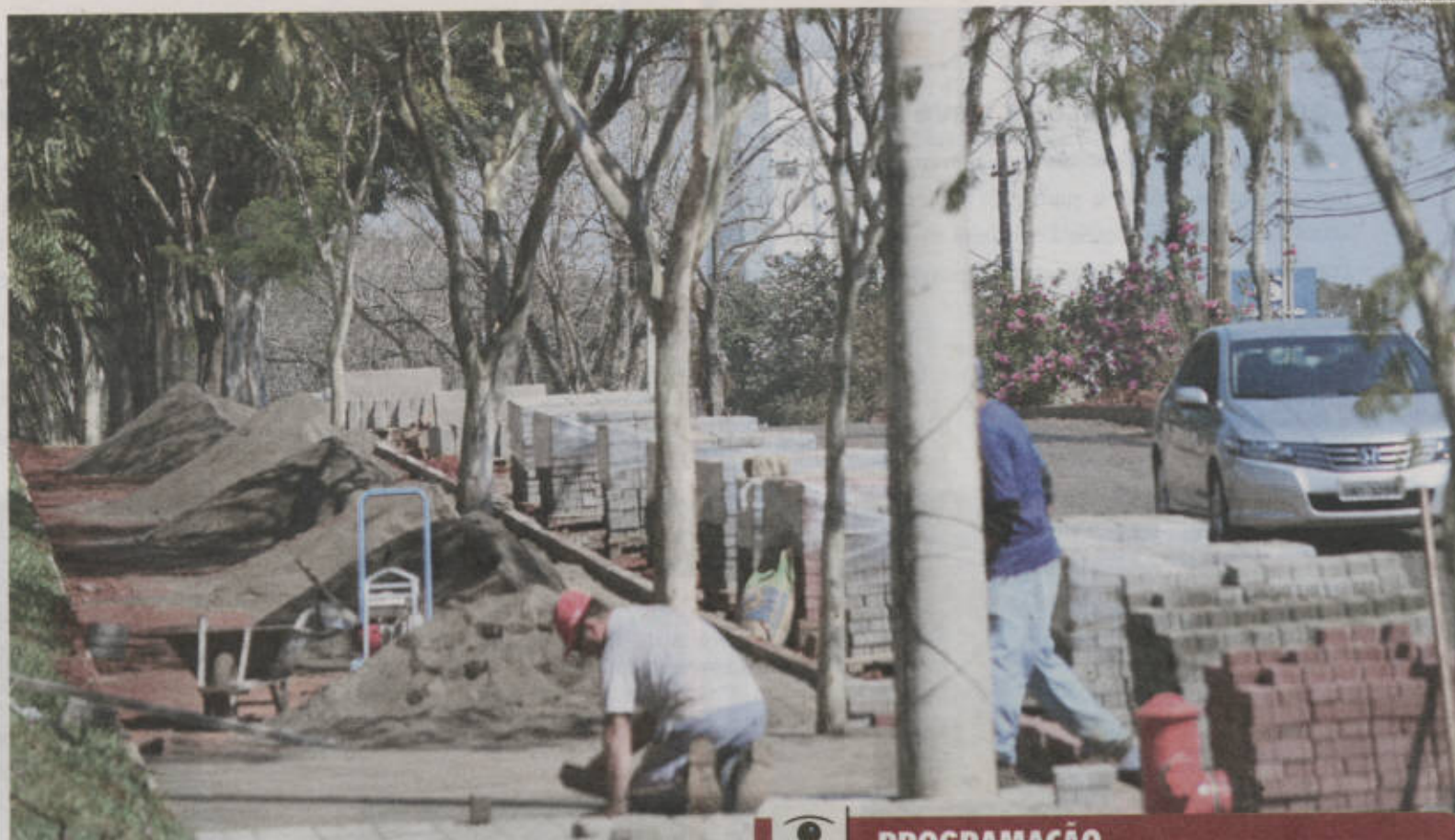
Asfaltamento e construção de calçadas no entorno do Parque do Imigrante estarão concluídas até a realização da feira. Pavilhões também são reformados
