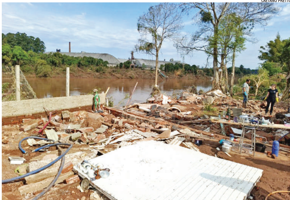
O bairro Conservas foi um dos mais atingidos em Lajeado
