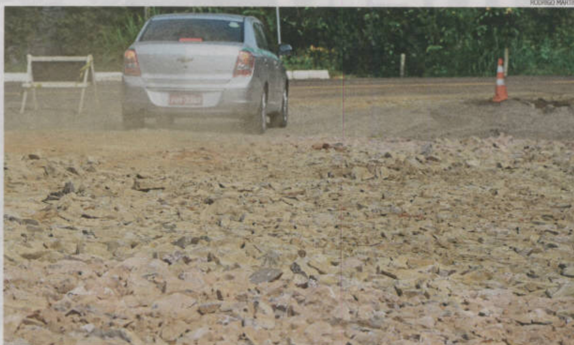
Em Lajeado, ruas vêm sendo pavimentadas por meio de empréstimos. Objetivo é garantir recursos próprios no futuro
