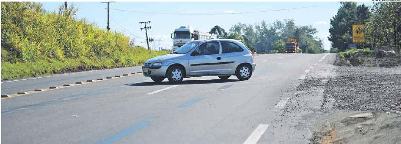
RISCO: veículos optam por troca de faixa perigosa devido a distância de rotatória
